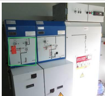
Sobre la foto, señalado el selector de la celda de línea. Photo shows the line switchgear panel outlined.
